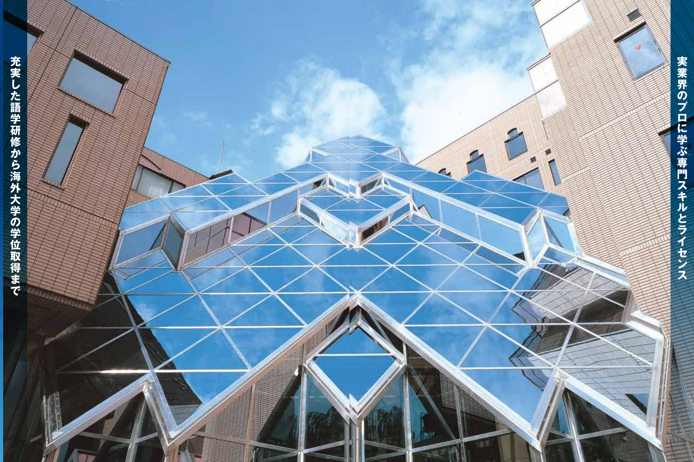
NFCCのシンボリックな建物「クリスタルホール」
